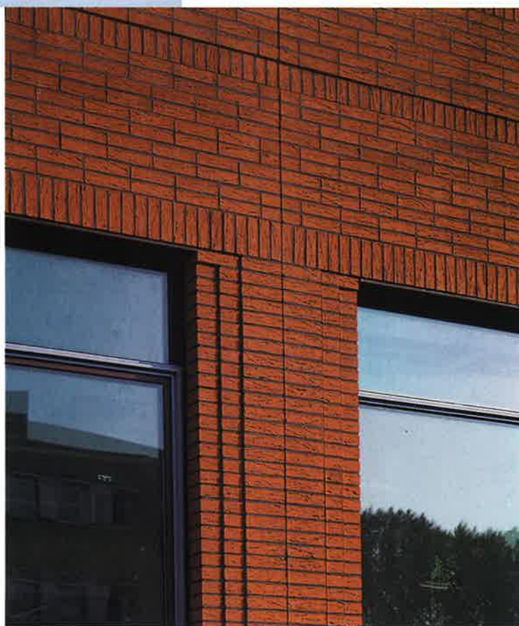
Gebouw Verbond van Verzekeraars, Den Haag (Atelier Pro)
