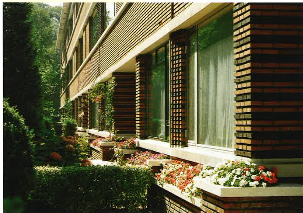
Woningbouw Van der Aastraat, Den Haag (Co Brandes)
