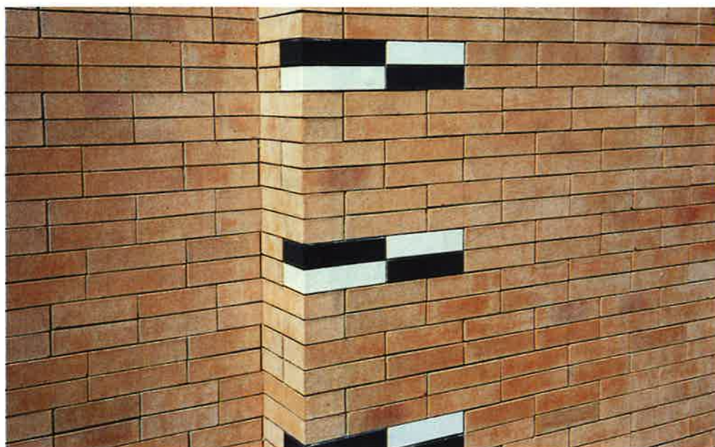
Verlijmden muur, verbindingstraat Molendijk-Vierwiekenplein, Oud-Beijerland (OD 205)
